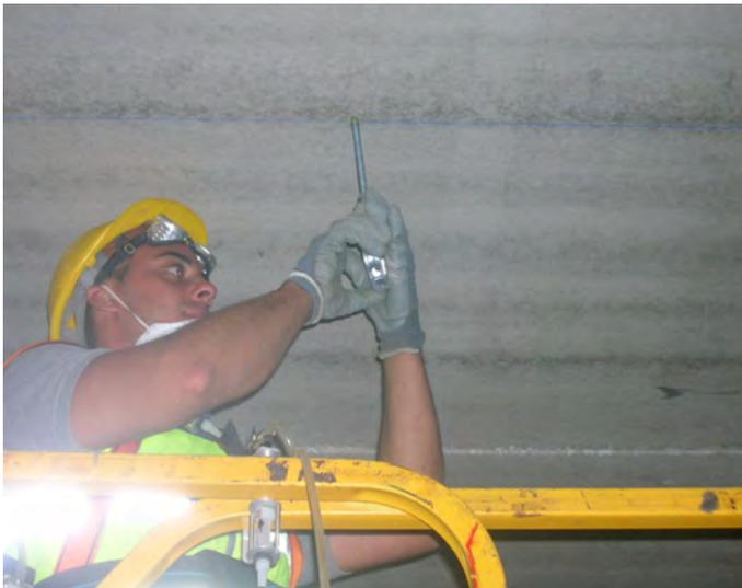
**I campionamenti personali evidenziano invece una elevata esposizione a silice libera cristallina durante l'attività di demolizione manuale delle pareti e la movimentazione di macerie.**
