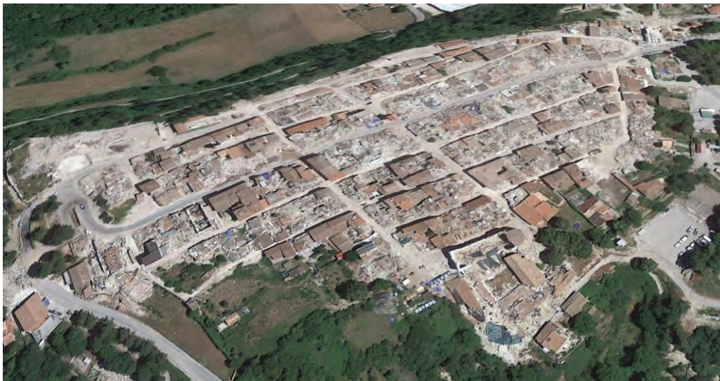
Figura 1 - Vista aerea del comune di Amatrice (RI) (fonte: Google Earth)
