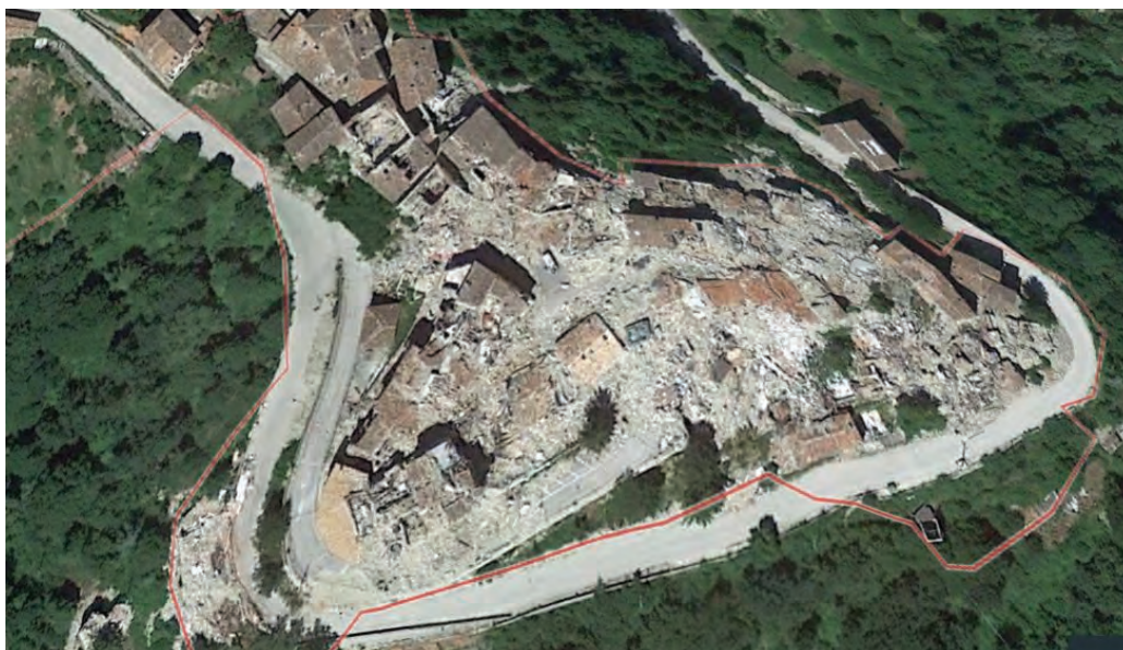
Figura 2 - Vista aerea del comune di Arquata del Tronto (AP) (fonte: Google Earth)
