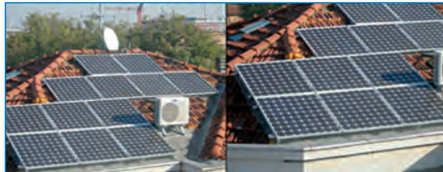
TIPOLOGIA SPECIFICA 1, caso A (tetto a falda con moduli che coprono una parte della copertura)
