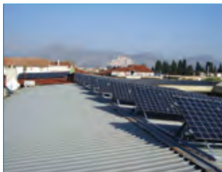
TIPOLOGIA SPECIFICA 1 (tetto piano). Qualora la soluzione proposta fosse simile a quella rappresentata in figura il riconoscimento dell'integrazione parziale non sarebbe concessa perché il tetto non è piano.
