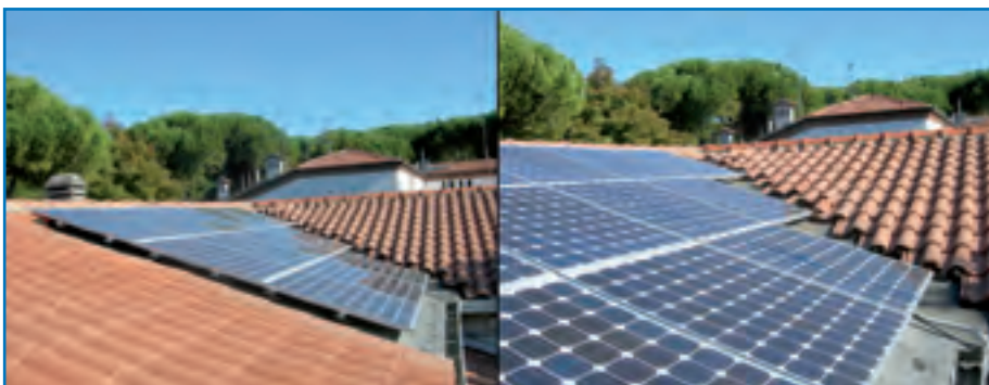
TIPOLOGIA SPECIFICA 1, caso A (tetto a falda con moduli che coprono una parte della copertura)
