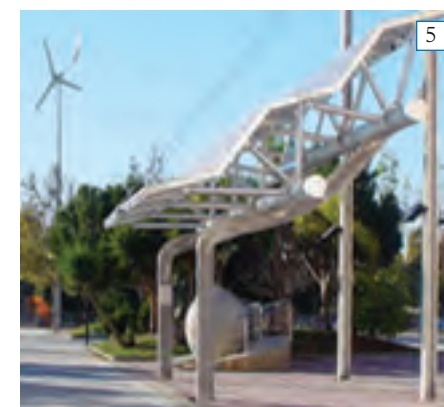
Fig.1, 2 - Pensilina ad Amersfoort, Olanda Fig.3, 4 - Pensilina Stazione ferroviaria, Svizzera Fig.5 - Pensilina fotovoltaica, Spagna
