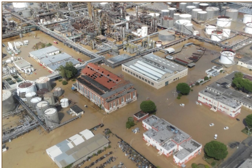
Foto 3 – Livorno, 10 settembre 2017. Allagamenti generalizzati nella zona industriale della raffineria ENI in località Stagno
