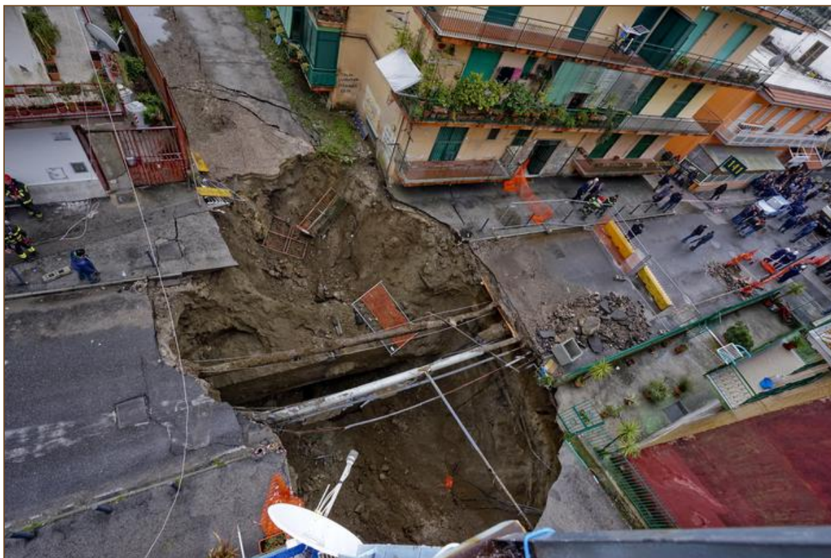
Figura 2.10.3 – Sinkhole antropogenico a Napoli; Pianura 3 marzo 2018, trecento ottanta persone evacuate
