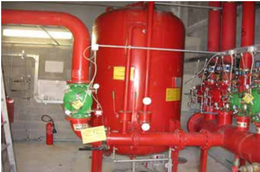
Figura 3. Impianto schiumogeno
