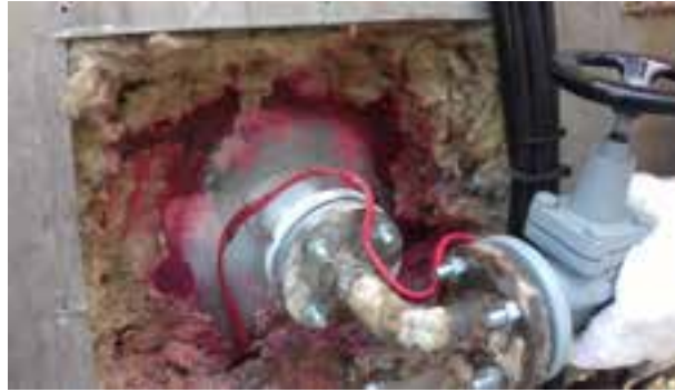
Figura 15. Connessioni presa d'acqua riparata con inserimento di nuovo bocchello flangiato e ripristino delle superfici del fasciame locale parzialmente corrosivo
