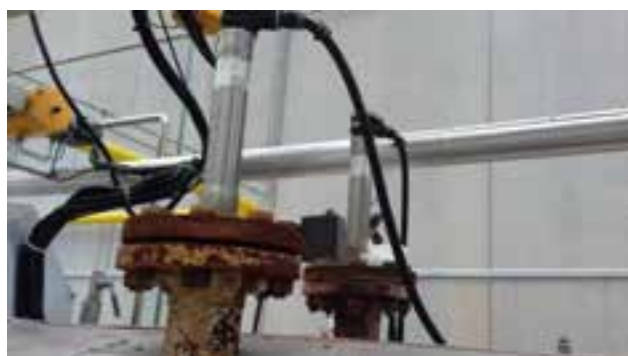
Figura 14. Connessioni scoperte di rivestimento o protezioni per inserimento sonde indicazione livelli e pressioni
