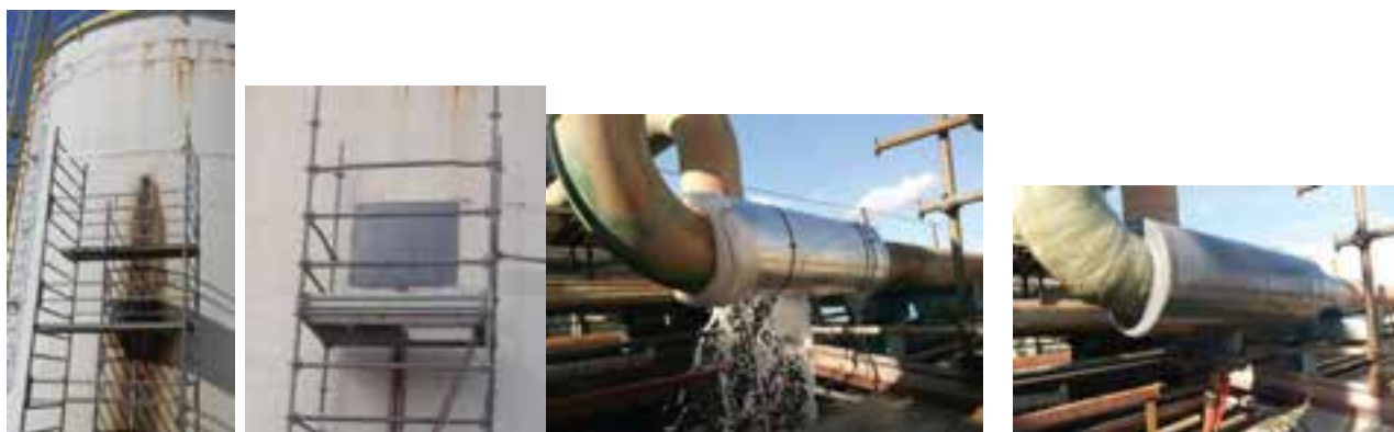
Figura 18. Esecuzione di rinforzi strutturali in presenza di perdite
