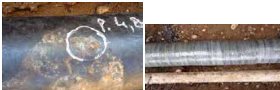
Figura 17. Esecuzione di rinforzo strutturale su tubazione ammalorata
