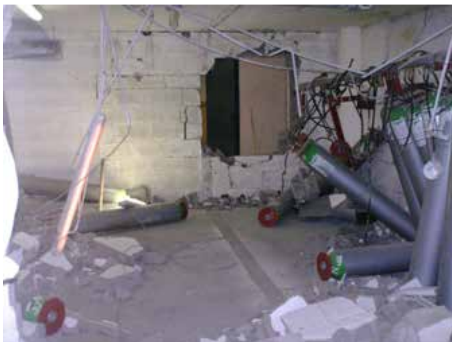
Figura 3. Effetti di una esplosione originata da impianto di spegnimento con gas inerte
