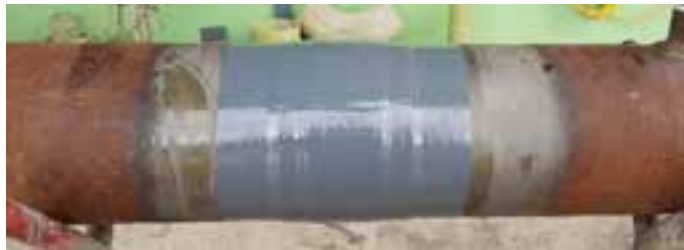
Figura 10. Completamento della riparazione mock-up
