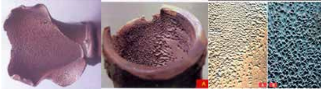
Figura 14. Componenti soggetti a FAC ed ingrandimento delle aree corrose
