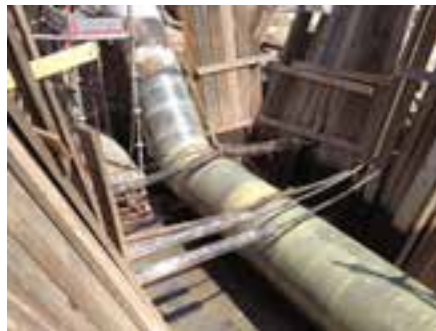
Figura 4. Rinforzo strutturale di una linea interrata
