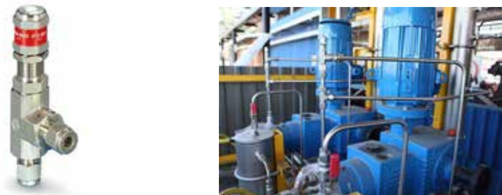
Figura 11. Valvole di sfioro pressione
