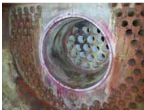
Figura 1. Attacco Focolare-Piastra tubiera
