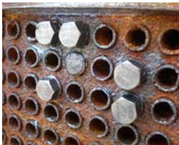
Figura 4. Tappi STP montati
