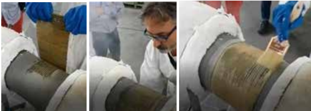
Figura 15. Varie fasi dell'esecuzione del rinforzo strutturale
