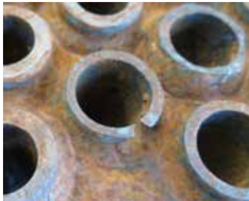
Figura 5. Esempio estremità tubo danneggiata
