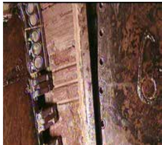
Figura 6. Fronte di scavo trattato con bentonite
