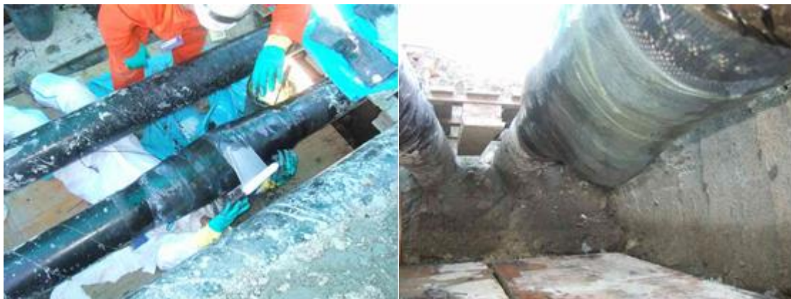
Figura 3. Fasi di lavorazione: in ordine di lettura realizzazione del composito P.R.S., aspetto finale della riparazione
