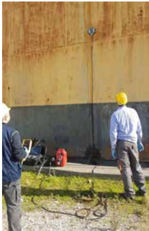
Figura 2. Serbatoio sul quale sono stati effettuati i rilievi
