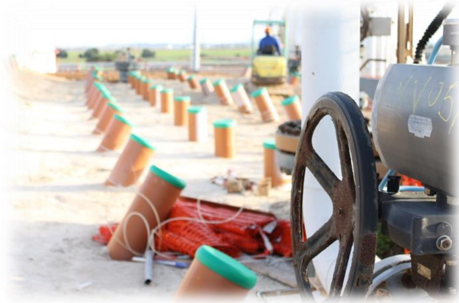
Figura 6. Esempio cantiere in lavorazione
