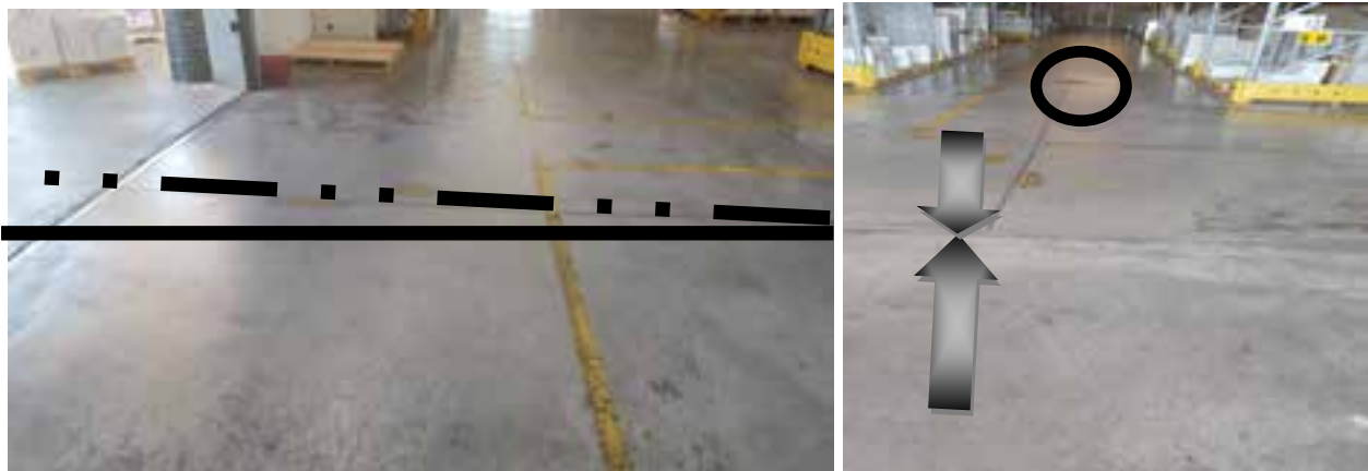
Figura 6. Azienda 2 - Contenimento di versamenti e schiuma – inclinazione pavimento
