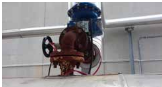
Figura 13. Connessione presa vapore scoperta
