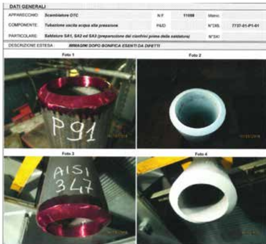
Figura 8. Rapporto Riparazione Centrale di Gissi - Preparazione dei cianfrini
