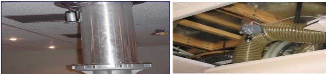
Figura 8. Tipologie di sensore ossigeno applicato sulla verticale della tubazione di quench
