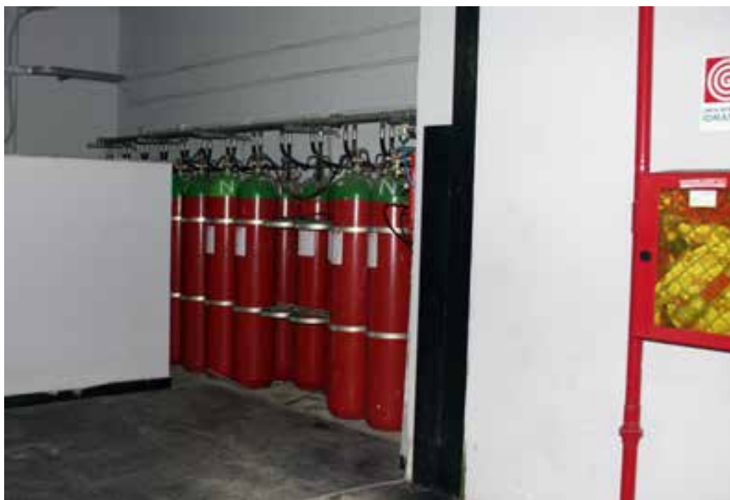
Figura 2. Pacco bombole di un impianto di spegnimento nella sua configurazione "normale"
