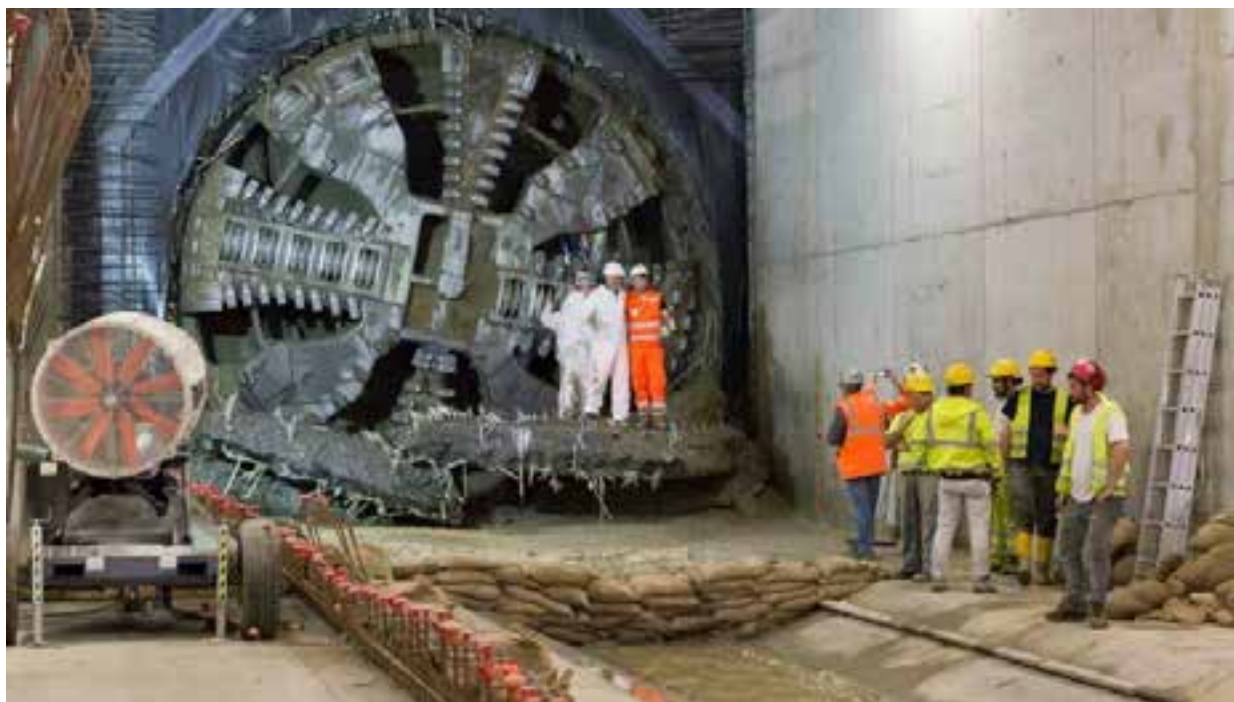
Figura 1. Particolare testa fresante di una TBM
