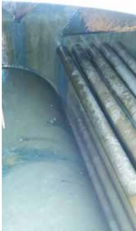
Figura 11. Tubi superiori al focolare dopo il lavaggio chimico
