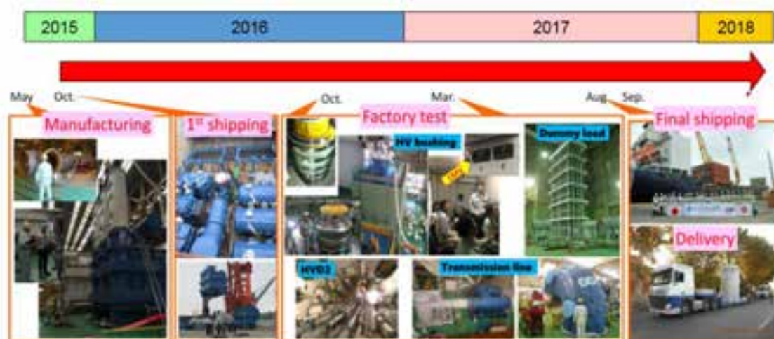
Figura 5. MITICA power supply : alcune foto testimonianti le fasi di avanzamento della sua installazione
