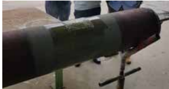
Figura 9. Esecuzione rinforzo strutturale
