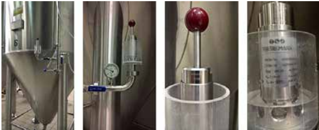
Figura 6. Ubicazione e particolare valvola regolazione CO2
