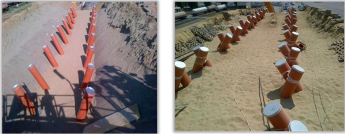
Figura 10. Disposizioni Tubazioni e reinterro delle trincee
