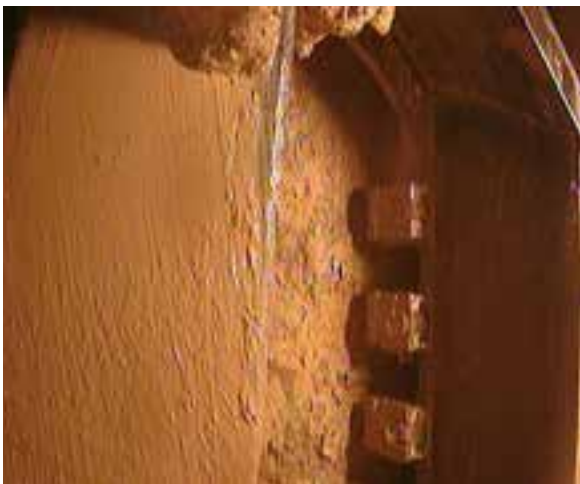
Figura 5. Fronte di scavo trattato con bentonite
