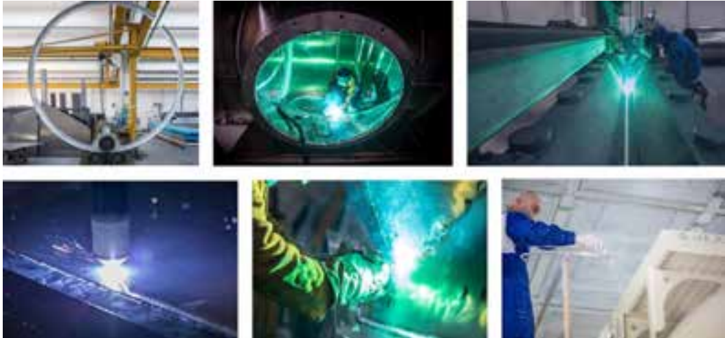
Figura 3. Fasi di lavorazione (Fonte: www.omeps.it )
