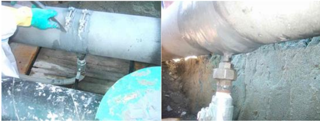
Figura 2. Fasi di lavorazione: in ordine di lettura sigillatura della zona della perdita con stucco epossidico, installazione della canalizzazione
