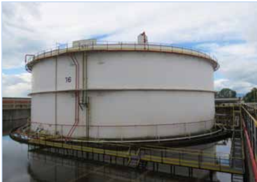
Figura 4. Serbatoio di stoccaggio a tetto galleggiante
