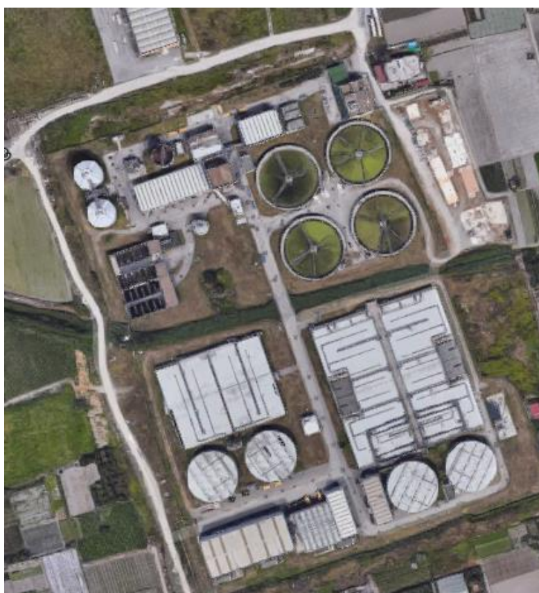
Foto 1. L'Impianto di depurazione di Sant'Antonio Abate/Scafati
