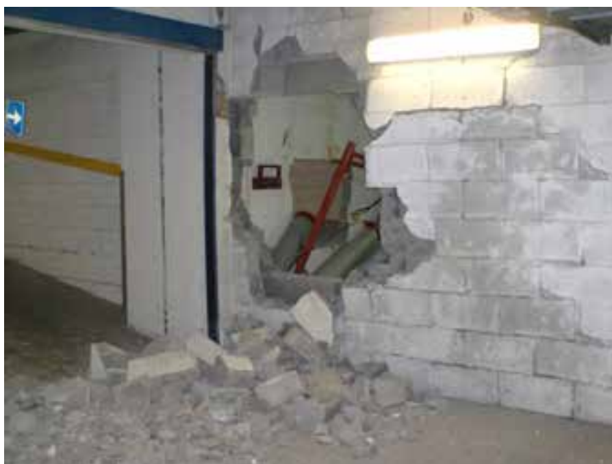
Figura 4. Effetti di una esplosione originata da impianto di spegnimento con gas inerte
