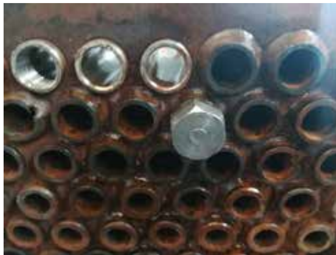
Figura 9. Installazione tappo STP conico
