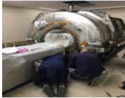
Figura 6. Apparecchiatura RM in fase di montaggio
