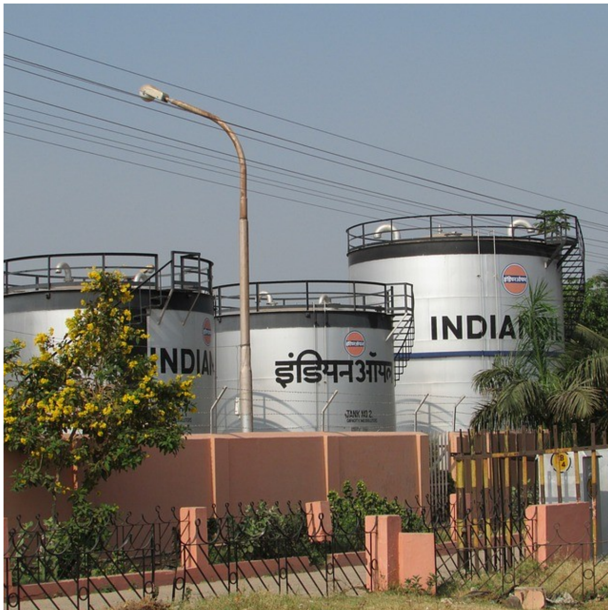
Figura 2.5 - Serbatoi fuori terra 13
