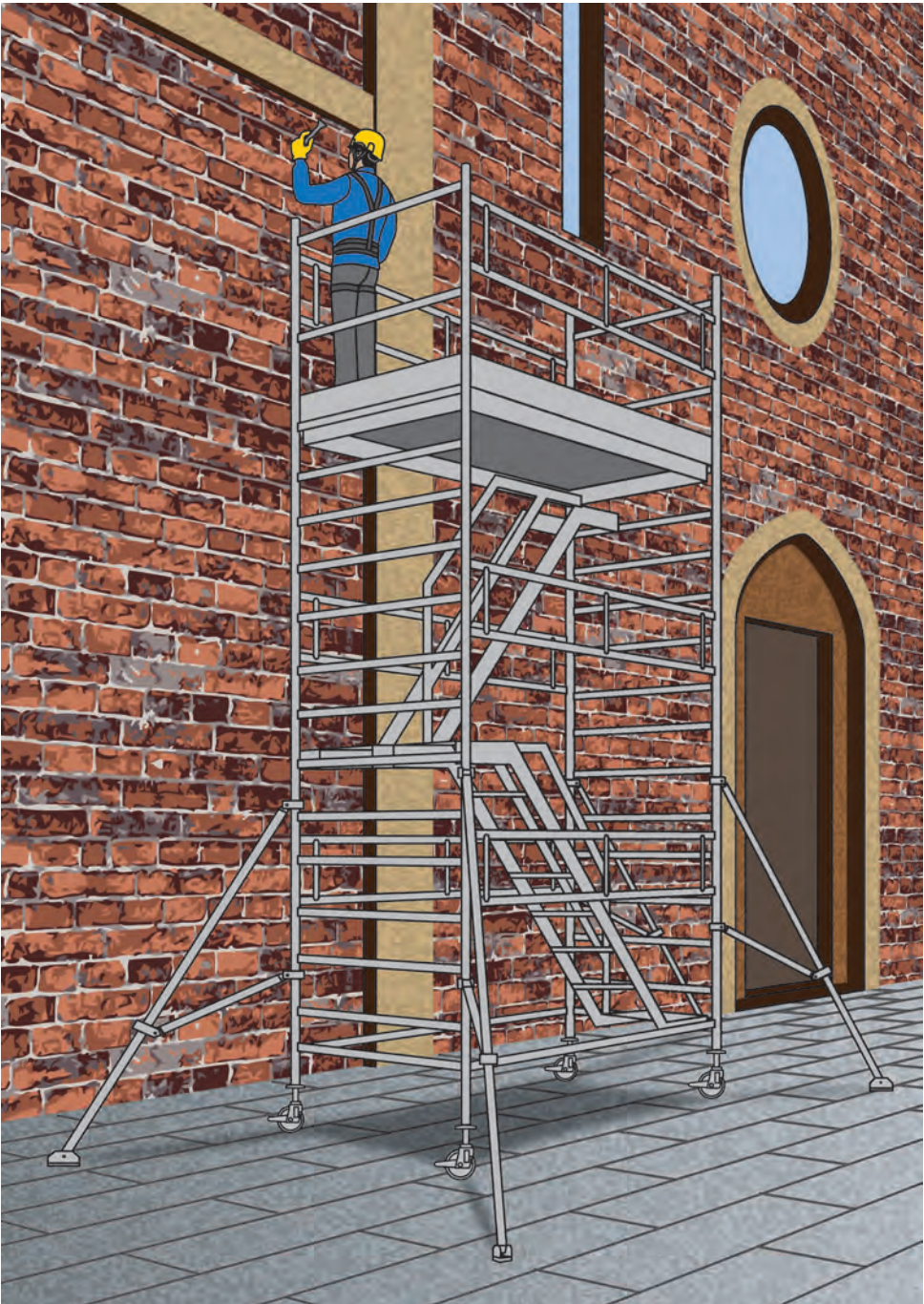
Figura 1 - Trabattello con scala a gradini
