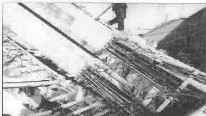
La restante parte del viadotto è stata realizzata con sistema classico, con pile a telaio ed impalcati tampone, identici in geometria e materiale. Gli impalcati tampone sono costituiti da 6 travi in calcestruzzo armato precompresso affiancate e collegate trasversalmente fra loro da traversi ad interasse di circa 9m, e soletta superiore. L'impalcato ospita due carreggiate con due corsie di traffico (marcia e sorpasso). La sezione trasversale è riportata nella figura seguente.
