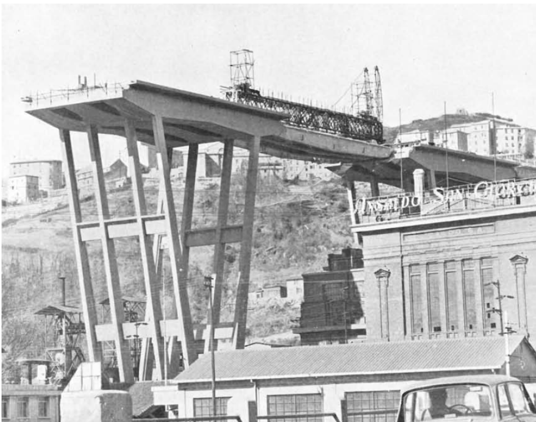
Fasi della realizzazione della travata prefabbricata sulla pila oggetto delle misure (c)
