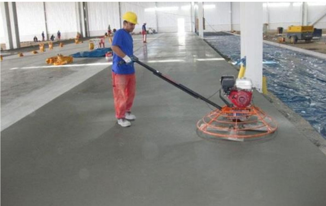
Fig. 4. - Elicotteratura calcestruzzo
