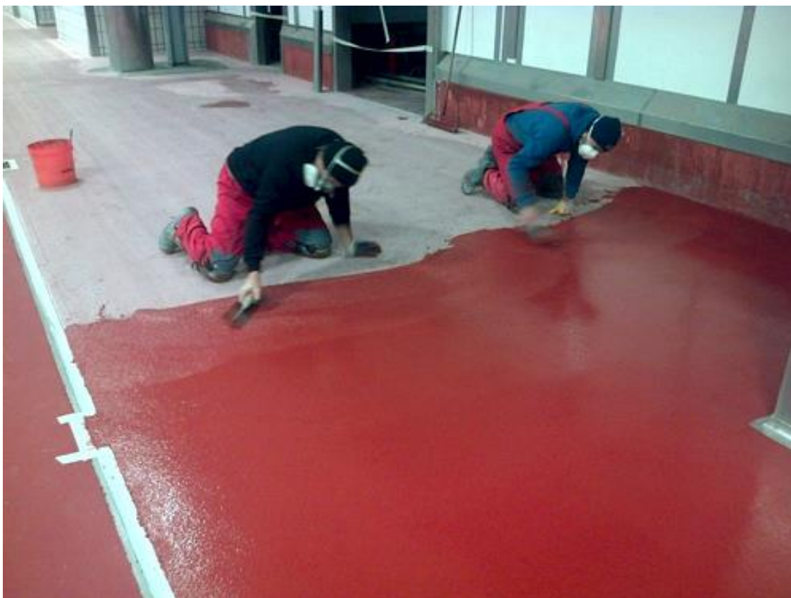
Fig. 5. - Stesura manuale resina
