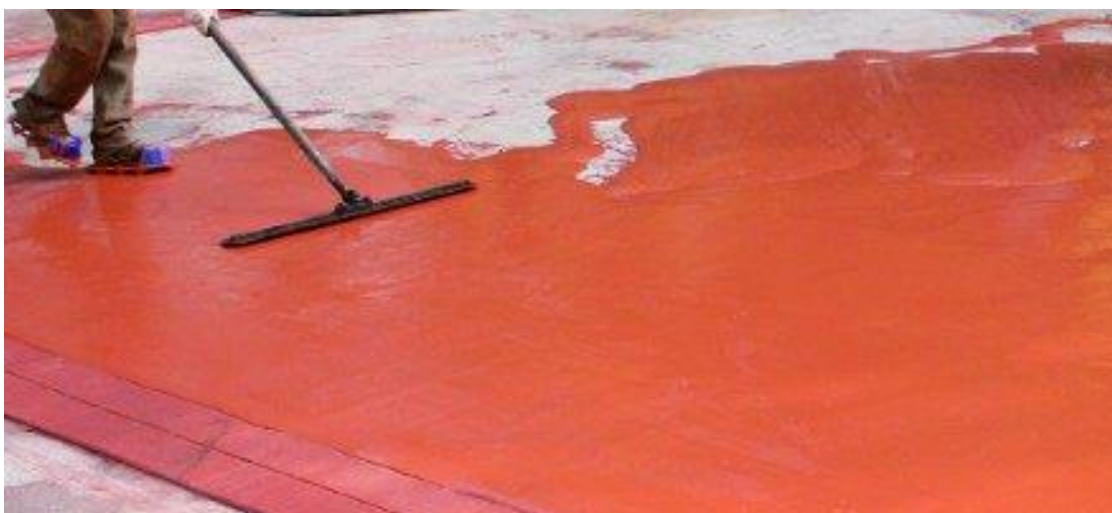
Fig. 6. - Stesura a staffa resina
