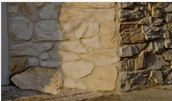
Figura 3 - Rivestimento in pietra con componente fotovoltaica integrata mimetizzata
